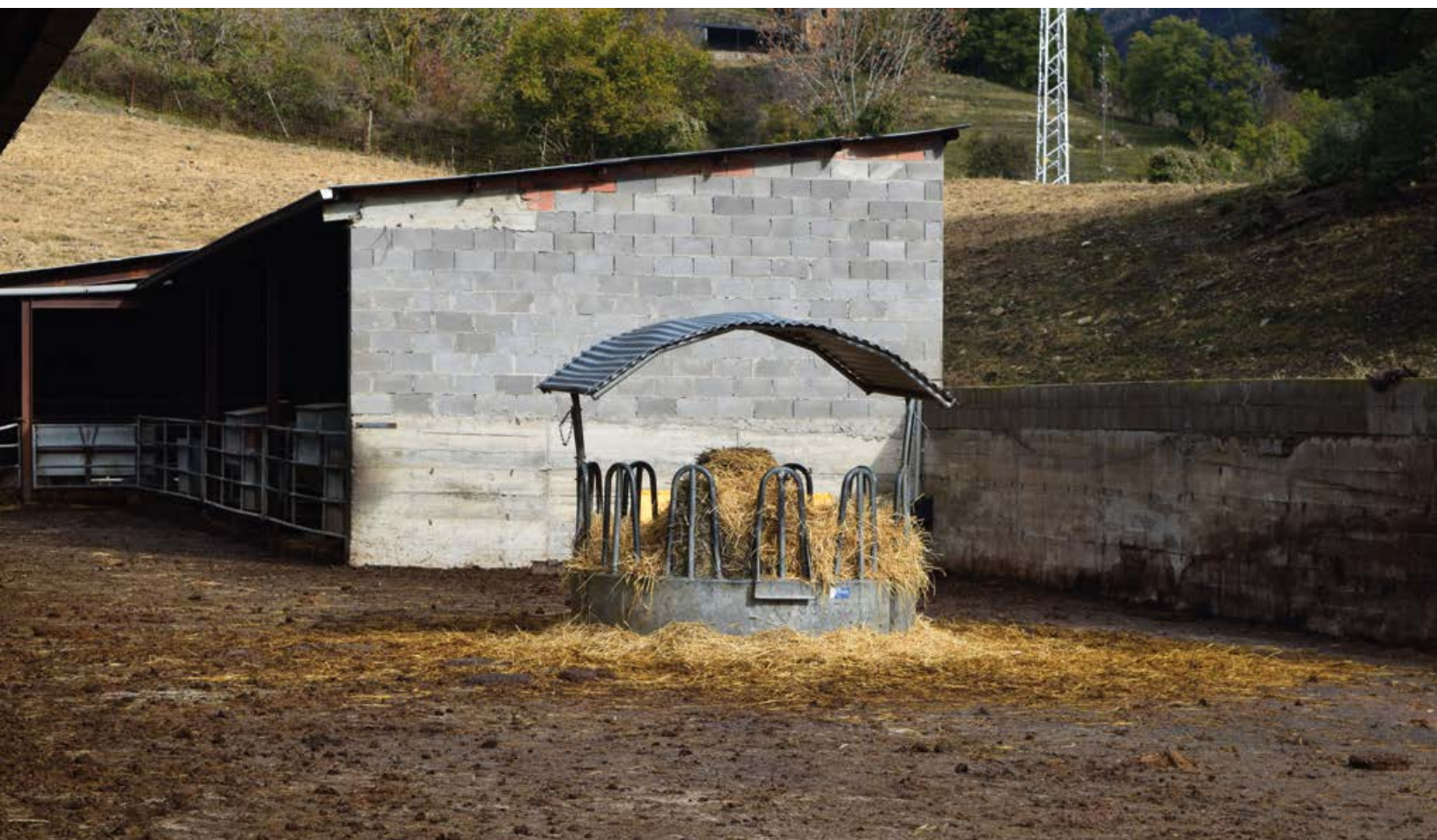
Figura 3.4.- Pajera en recinto cerrado con techo propio.
